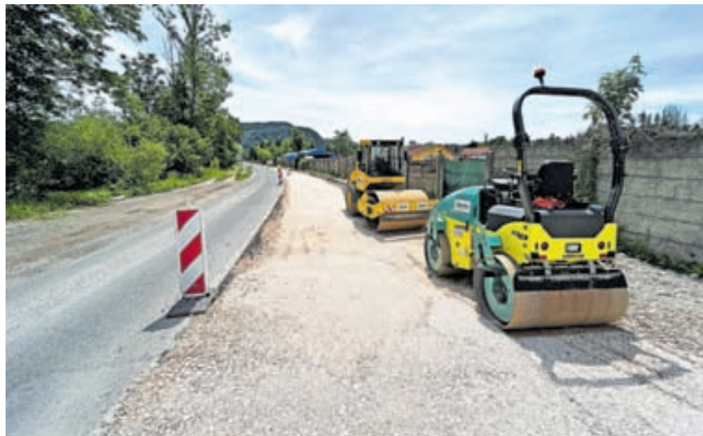
Na cesti Fužine–Spodnje Stranje Komunalno podjetje Kamnik izvaja sanacijo vodovoda, država pa bo cesto tudi preplastila. / FOTO: ALEŠ SENOŽETNIK
