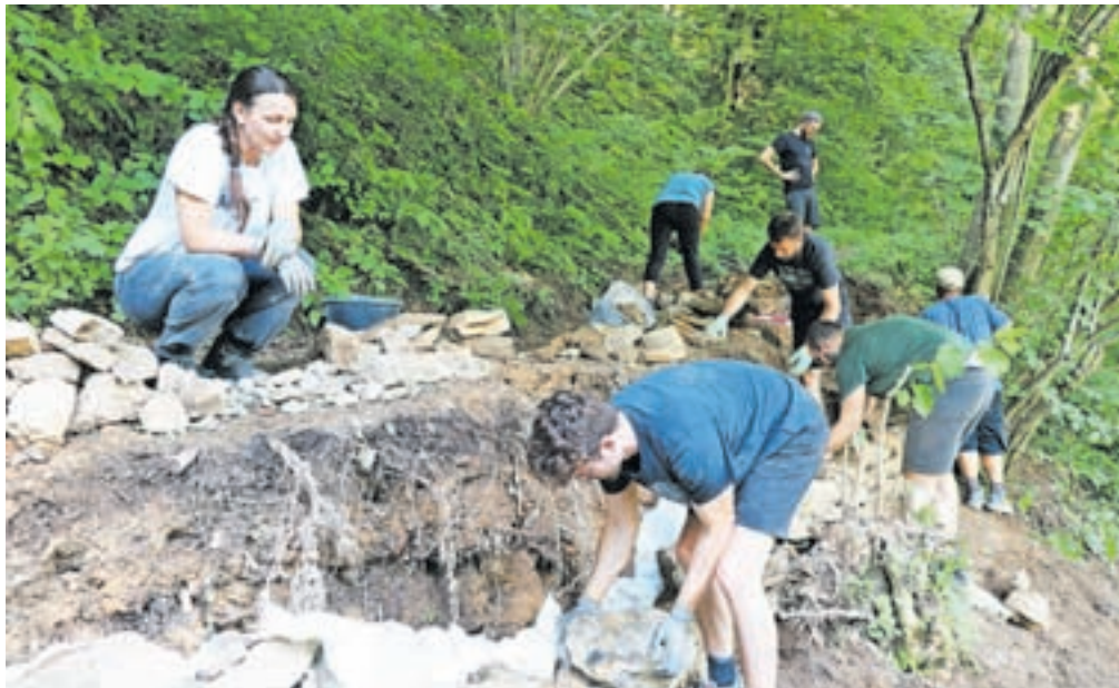
Pri suhi gradnji so uporabili skale, ki so jih dobili na kraju gradnje, podrli pa so tudi nekaj originalnih zidov, ki so bili posedeni, in so jih postavili nazaj. / Foto: Vilma Stanovnik
