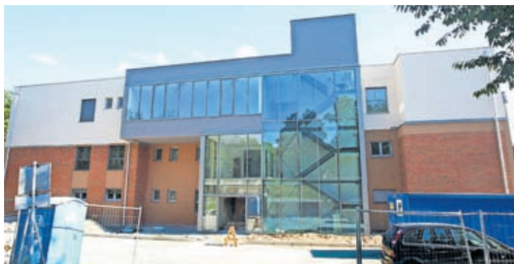
Dela na Osnovni šoli Jela Janežiča bodo končana proti koncu junija. / Foto: Gorazd Kavčič
