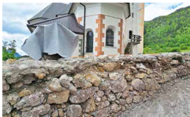
Sanacija pokopališkega zidu ob cerkvi na Dovjem
