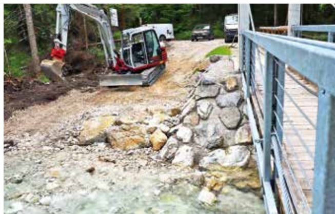
Izvedba protipoplavnih nasipov ob novi brvi čez Triglavsko Bistrico pri Peričniku
